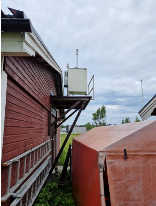
Figur 3. Mätstationen vid taknocken.
